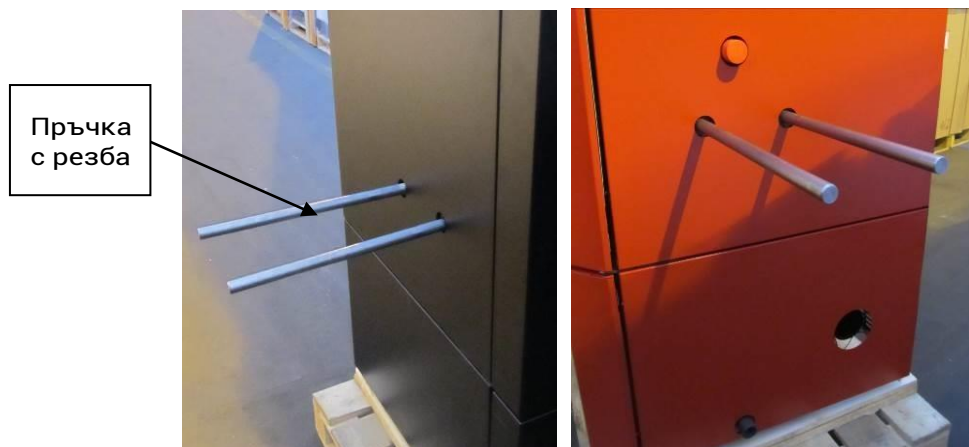
Фигура.1 Манипулиране на котела с помощта на пръчководни носачи
